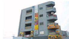
クインビル JR石山駅前 1棟管理
