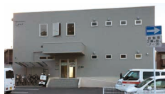
三菱電機ビルテクノサービス 滋賀支店
